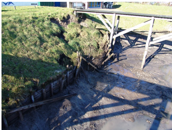
herstel walbeschoeiing onder grote schans
