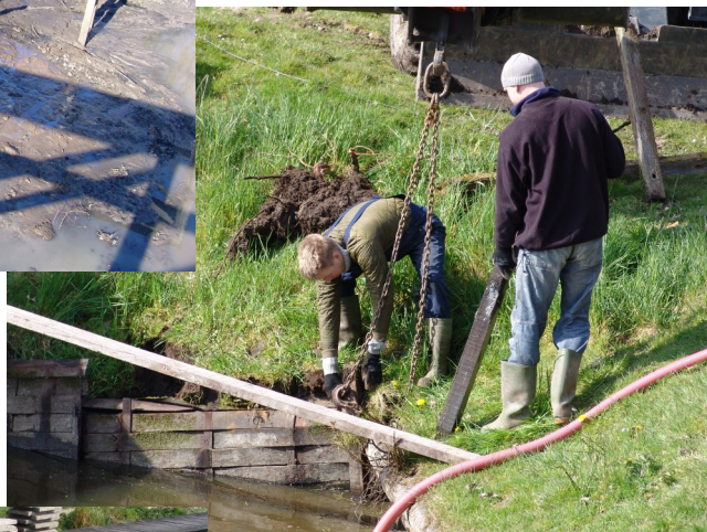
herstel walbeschoeiing onder grote schans
