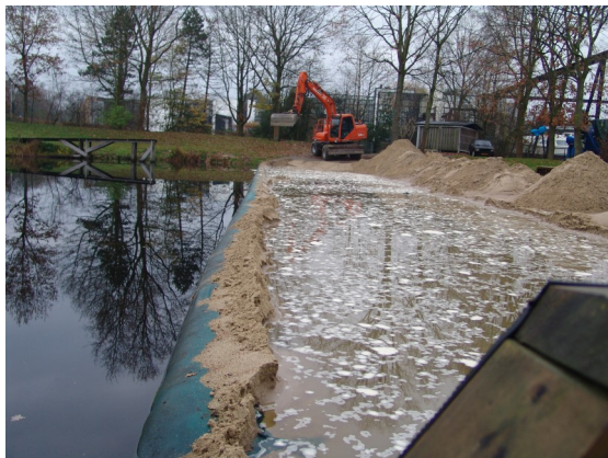
januari 2008 aanbrengen walbeschoeiing door Siderius
