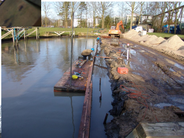
januari 2008 aanbrengen walbeschoeiing door Siderius
