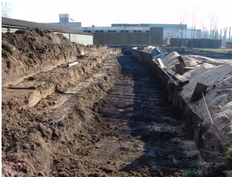
duidelijk te zien hoeveel bre- der het zandbed wordt
